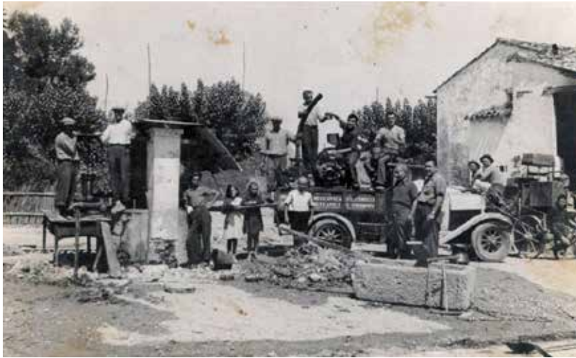
Lavori al pozzo nei pressi del casale
