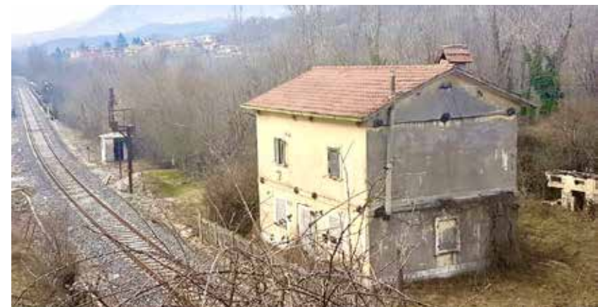
Il casello di Balsorano, oggi un rudere
